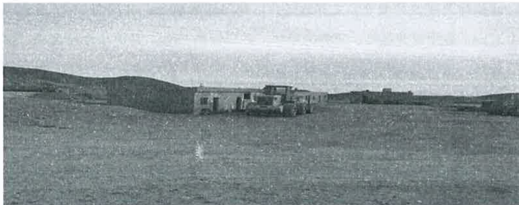
照片 1-15 井旁值班休息室
